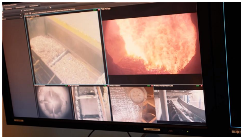
Рисунок 3 – Система видеоконтроля, установленная на производстве энергии из отходов.
