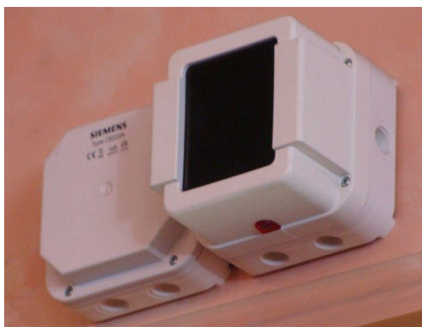
Рис. 2.8. Линейный дымовой пожарный извещатель
