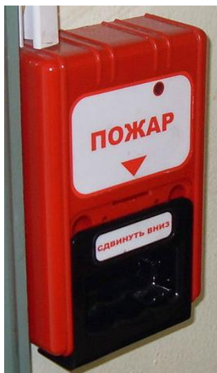
Рис. 2.4. Ручной пожарный извещатель
